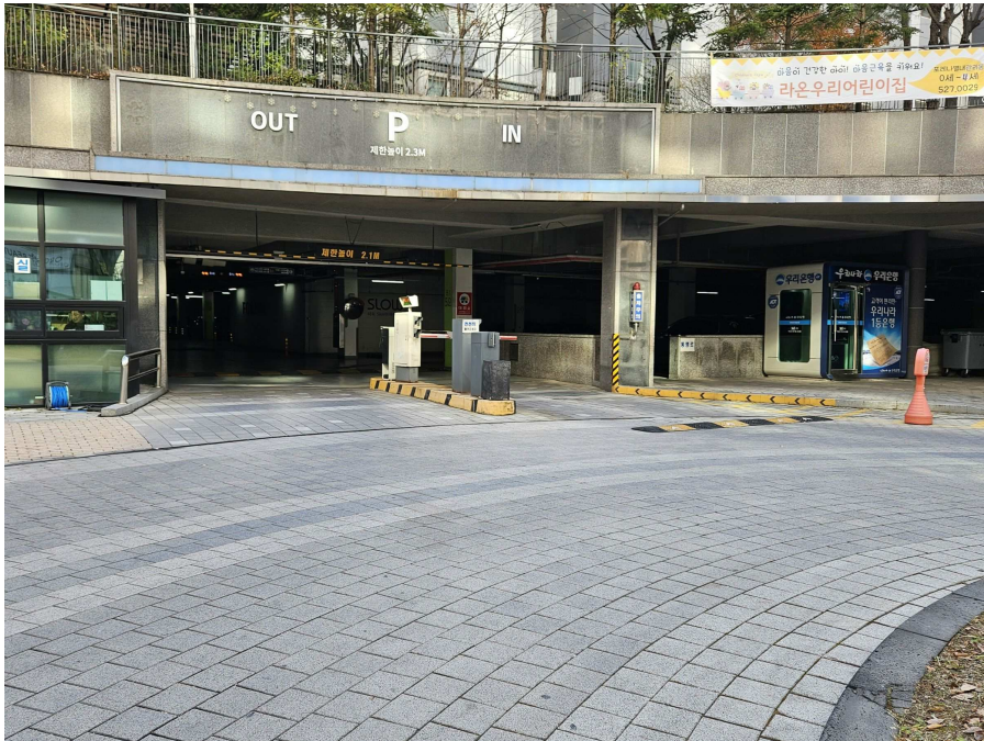
지하 주차장 출입구
