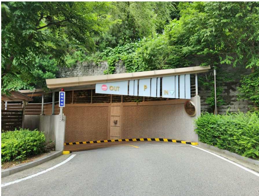
기호(2) 지하주차장 출입구
