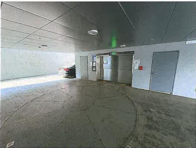
본건 기계식 주차시설
