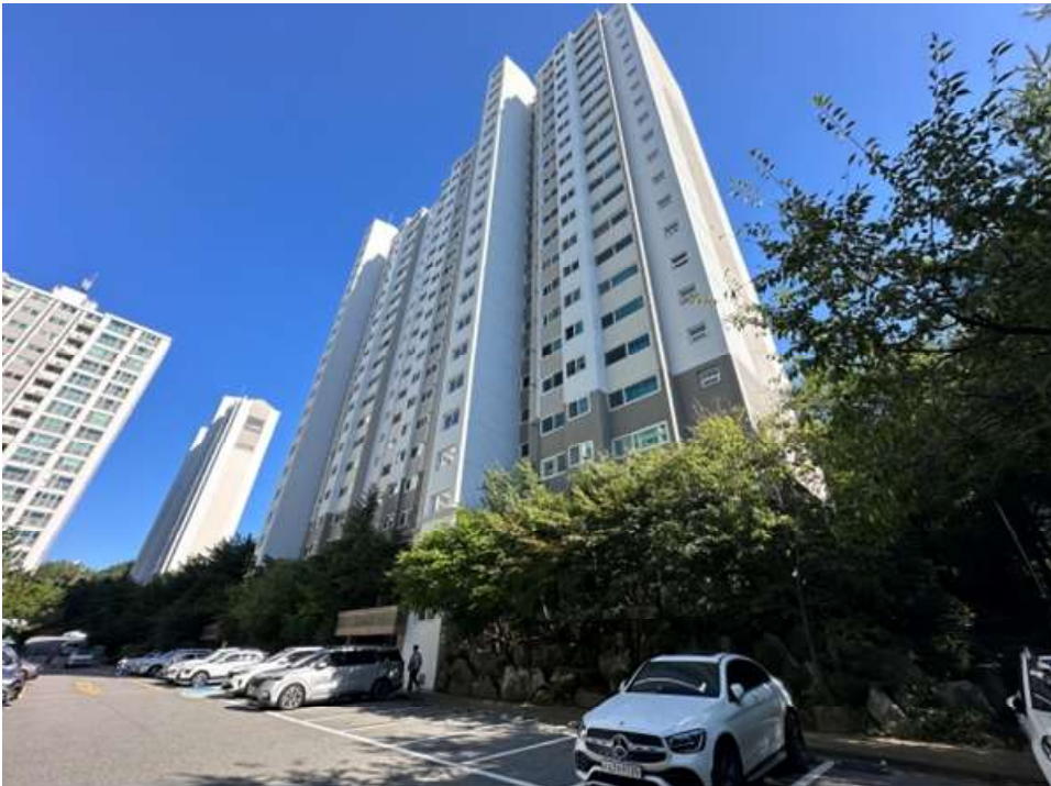
본건 건물(2206동) 전경
