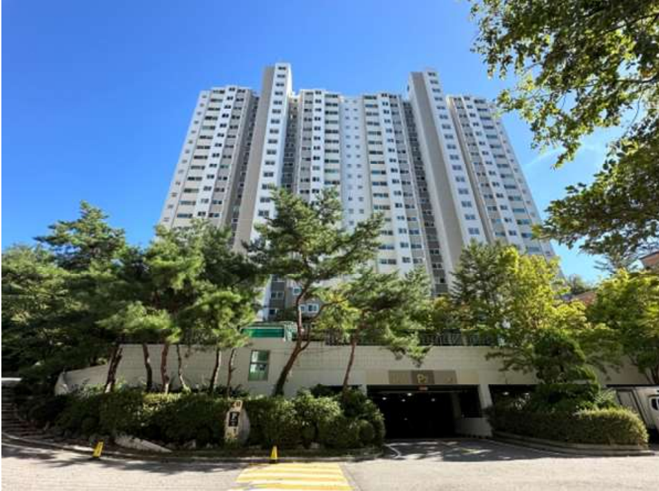
본건 건물(2206동) 전경
