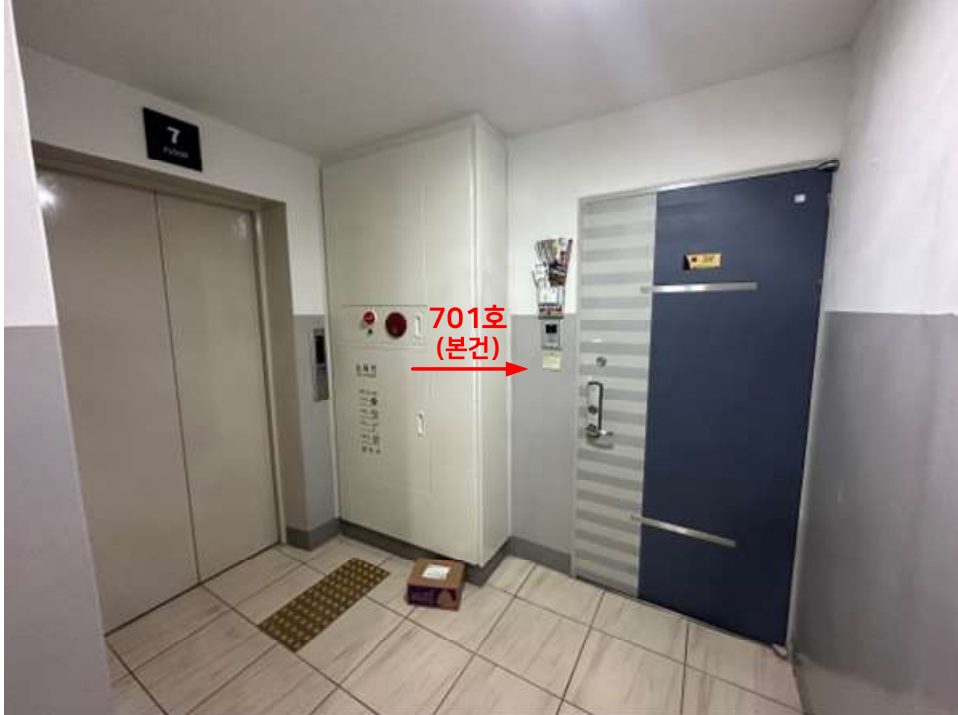
본건 건물(2206동) 1,2호 라인 7층 복도 등
