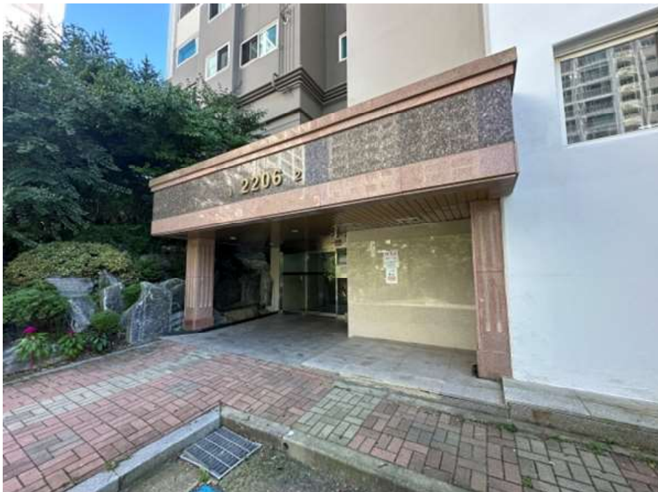
본건 건물(2206동) 1,2호 라인 지층(L층) 출입구 전경
