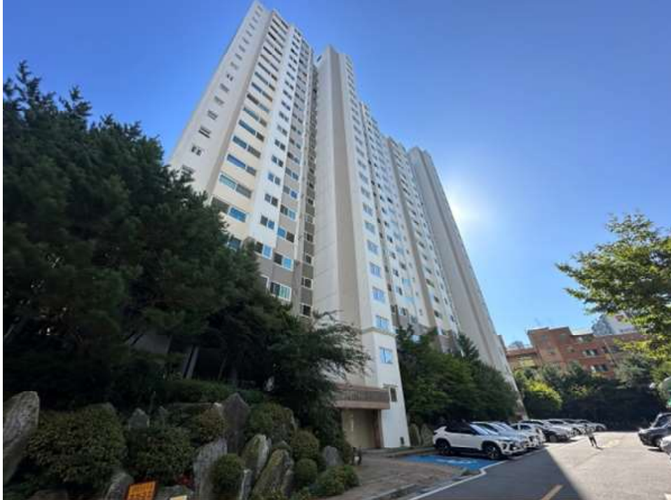
본건 건물(2206동) 전경
