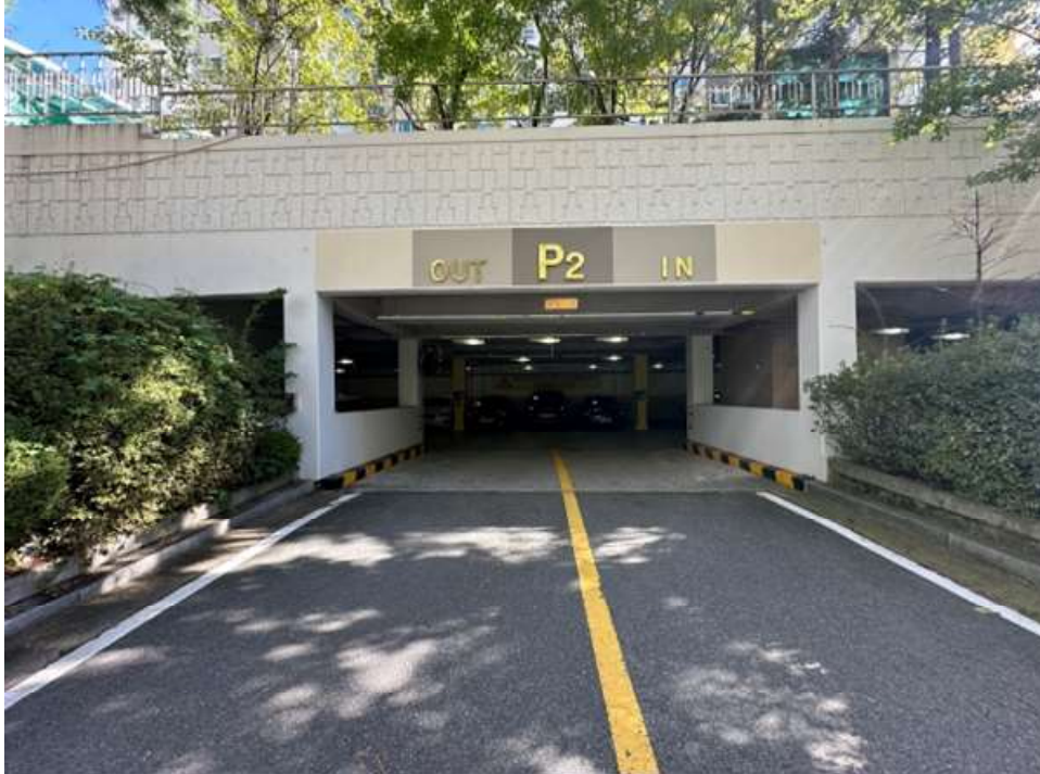
본건 단지내 지하주차장 출입구 전경
