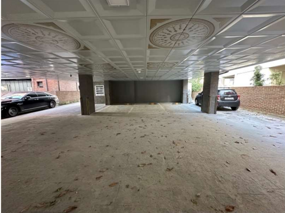
본건 건물 1층 주차장 전경 등
