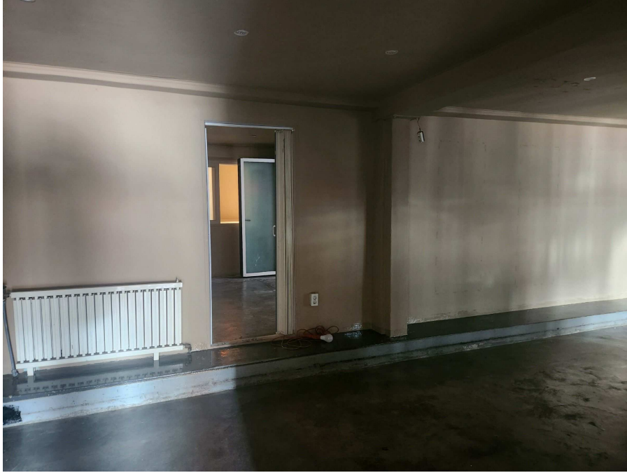
기호 2 건물 : 1층 내부전경
