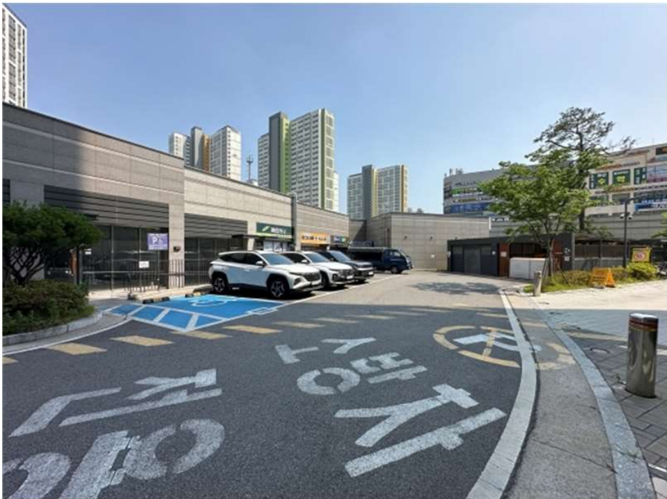
본건 건물 지상 주차장 전경
