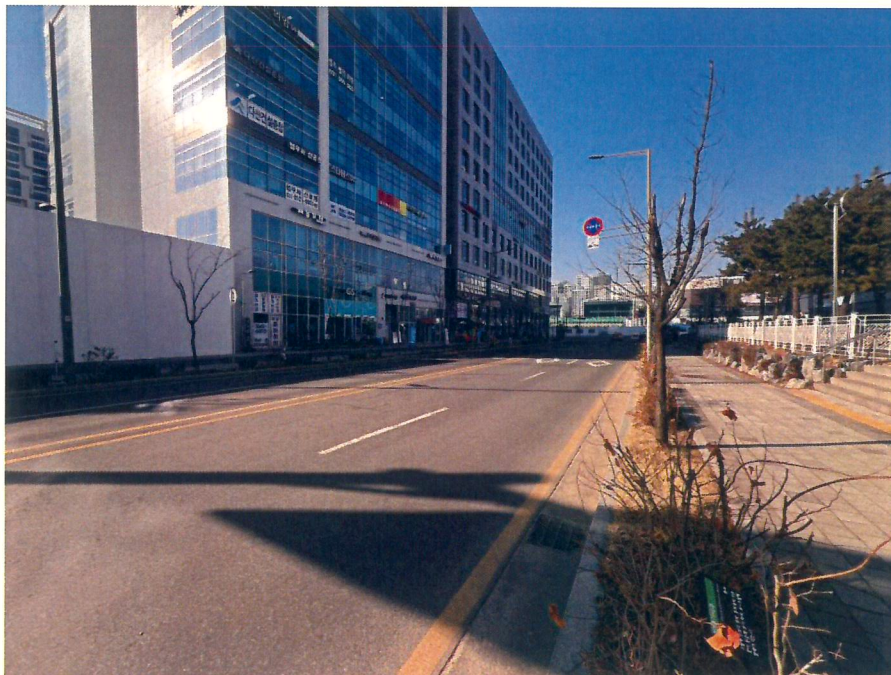
본건 건물 북동측 인접도로
