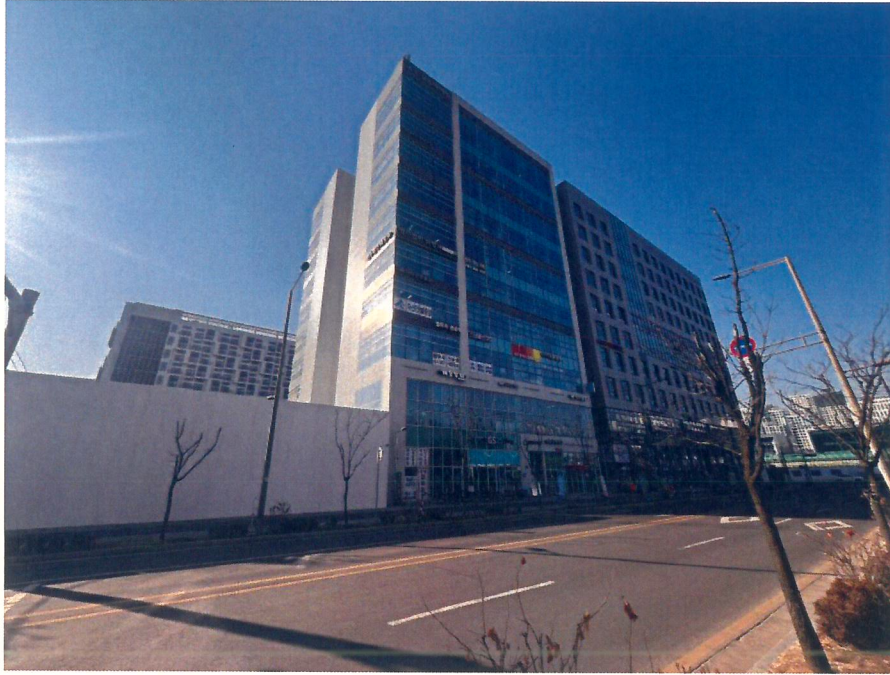
본건 건물 전경
