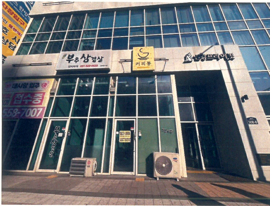
본건 전면 전경
