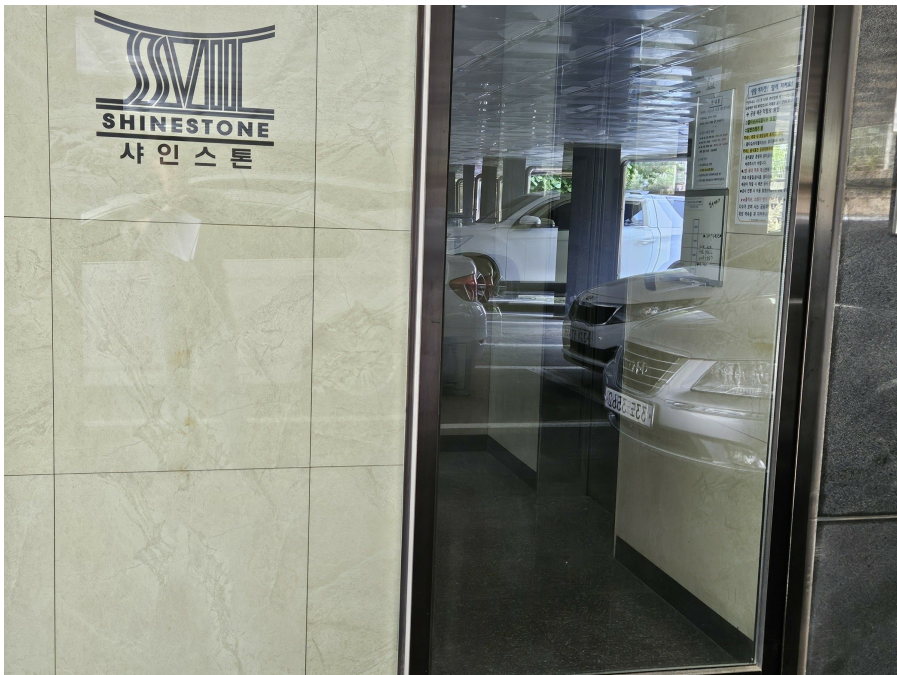
본건 동 1층 출입구
