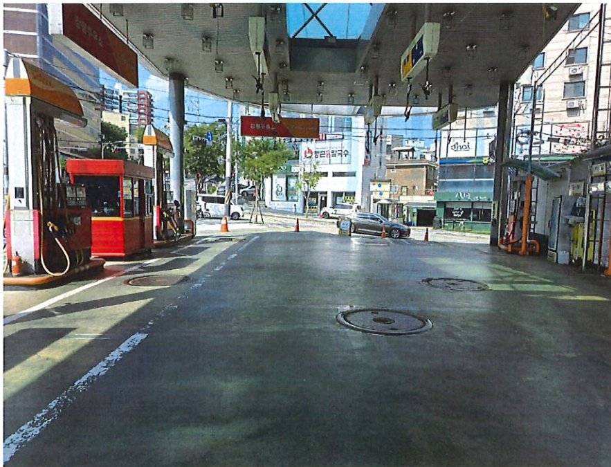
제기외기계기구 ⑭ 전경
