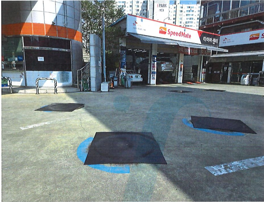
제기외기계기구 ⑭ 전경
