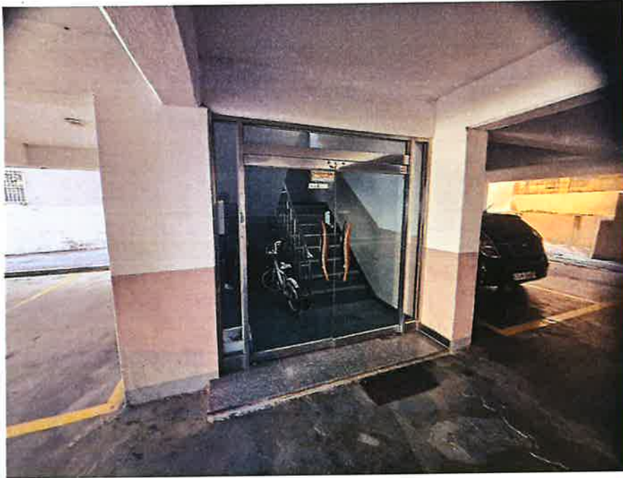
대상물건 일련번호 가) 공동현관문 촬영
