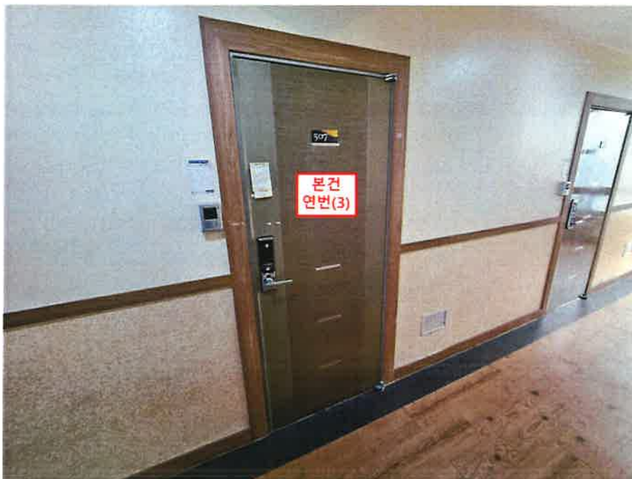
본건 연번(3) 현관문 전경
