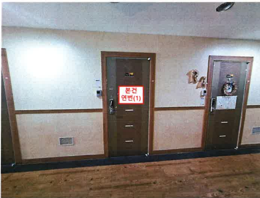
본건 연번(1) 현관문 전경
