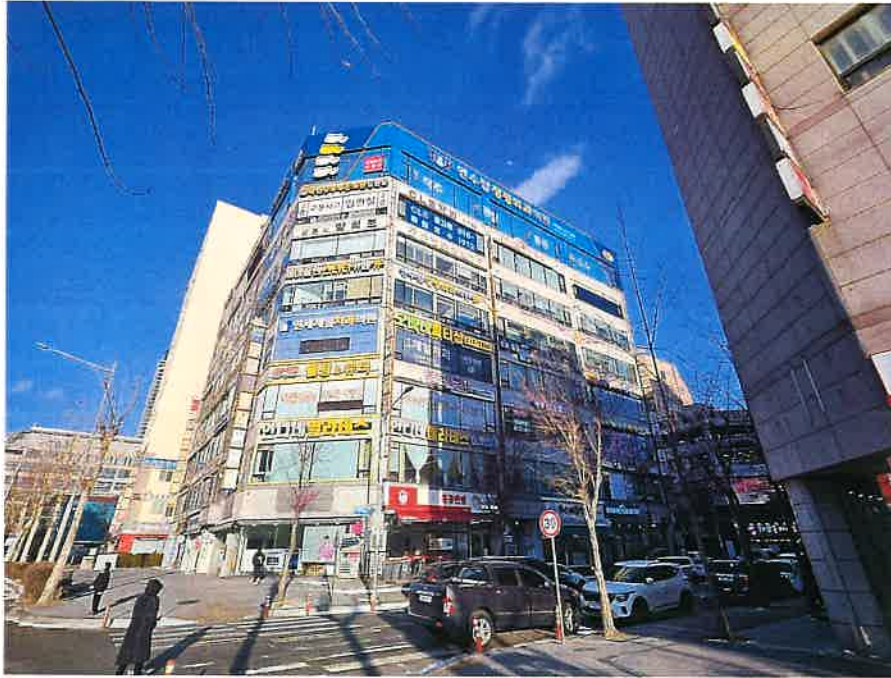
본건 연번(1~3)이 속한 건물의 전경
