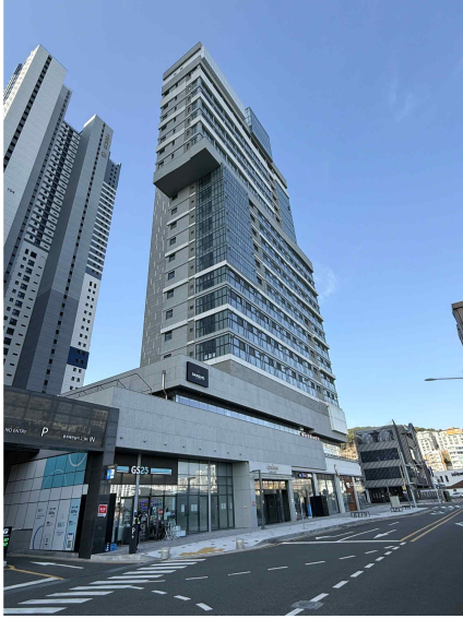
본건 건물 전경
