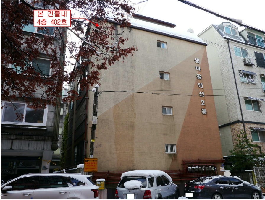
본건동(삼마을맨션 통칭 '2동') 전경
