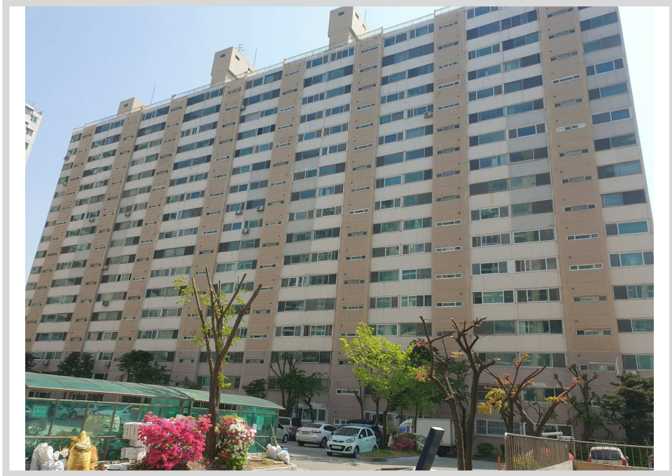
건물 북측 전경
