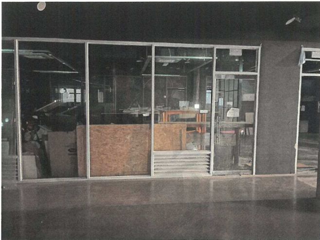
본건 전경(지1층 전경)
