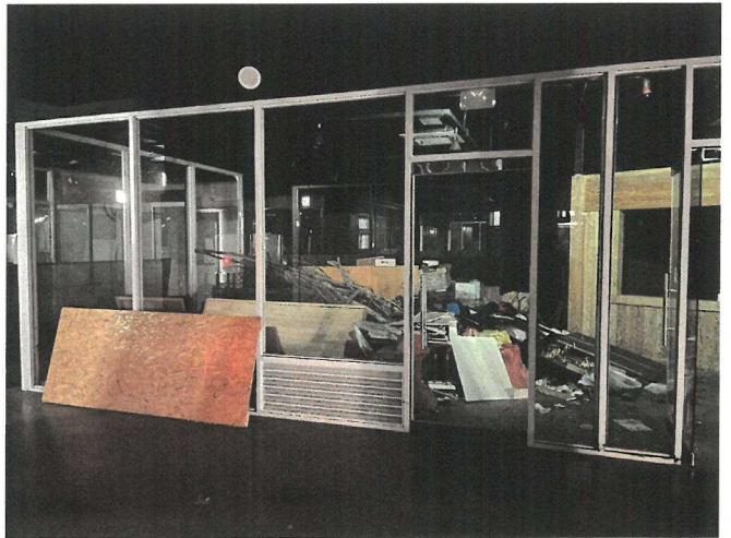
본건 전경(지1층 전경)
