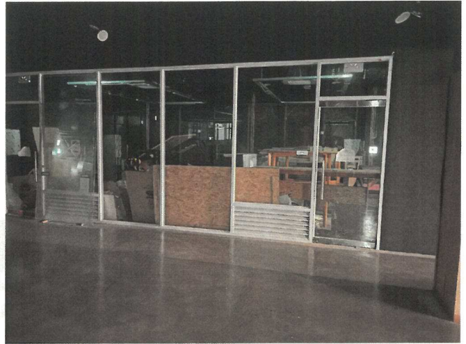
본건 전경(지1층 전경)
