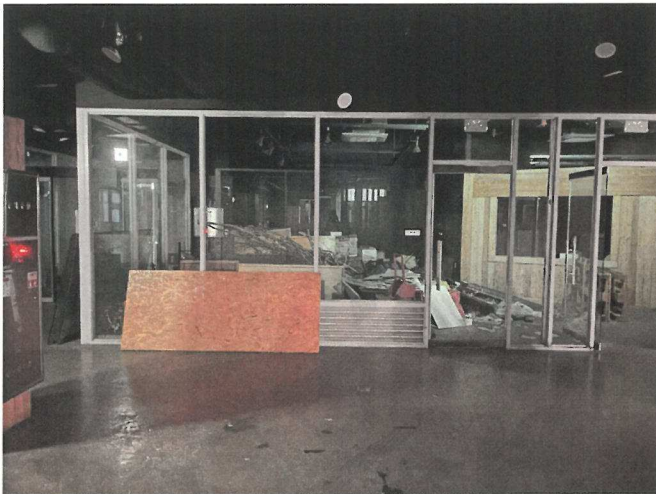
본건 전경(지1층 전경)
