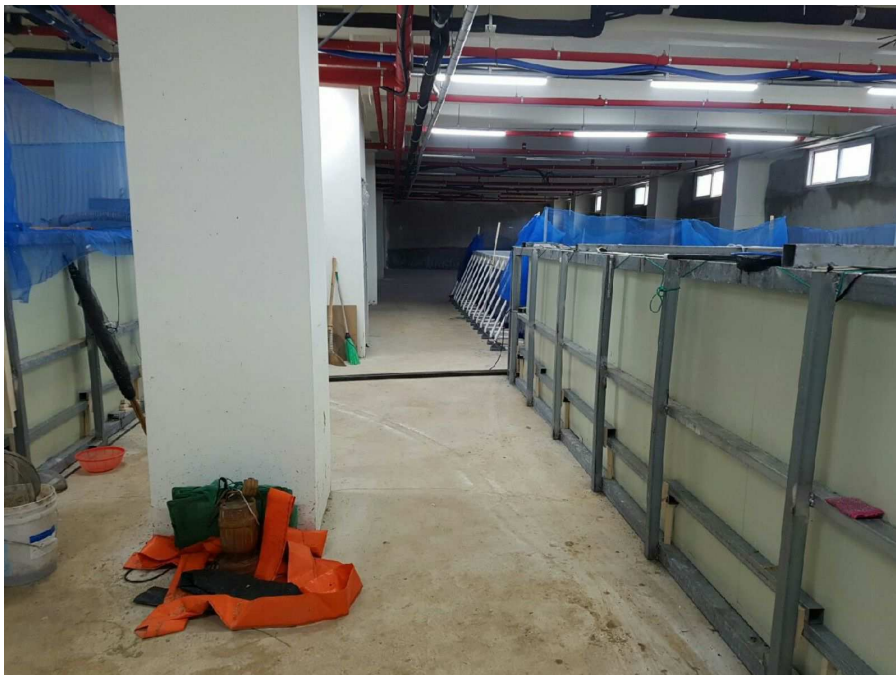
본건 건물 지하
