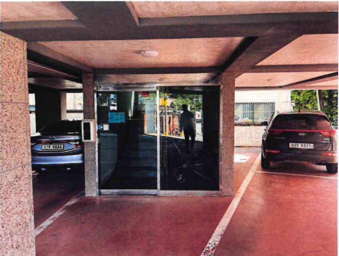
본건 공동현관문 출입구 사진
