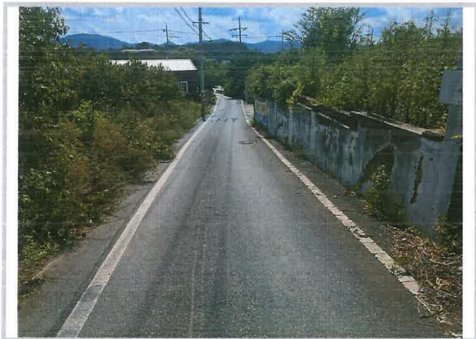
기호(4) 토지(도로) 전경
