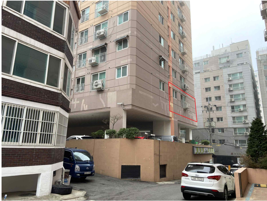
대상물건 전경 (북동측에서 촬영)
