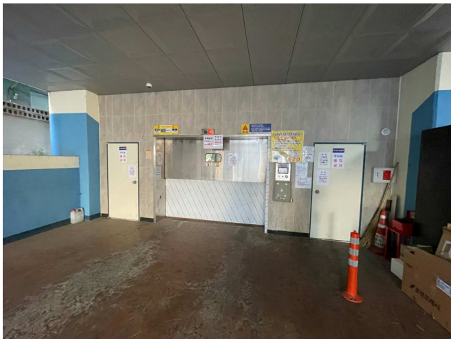
본건물 기계식 주차 설비
