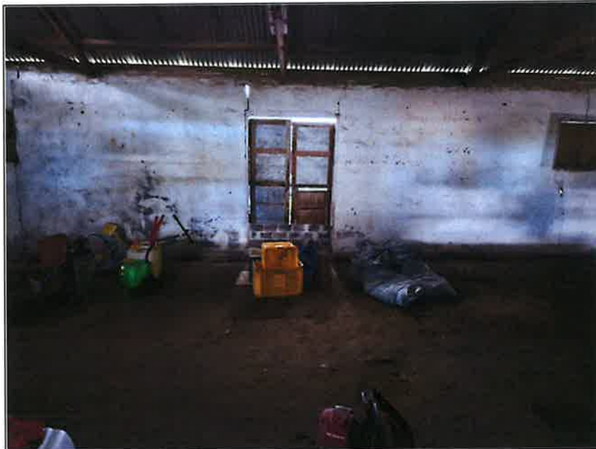
[ 제시외건물(ㄷ) 내부 전경 ]
