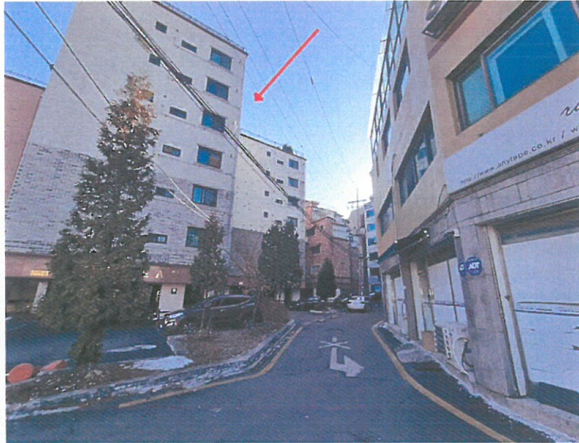
【본건전경 및 주위환경(북동측에서 촬영)】
