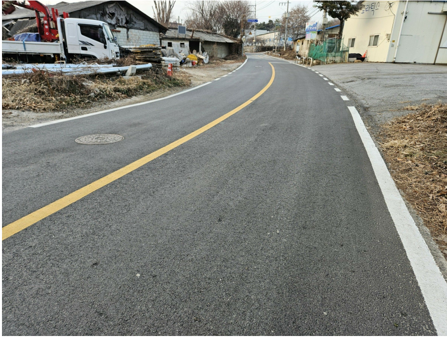
접면 도로(기호 1, 3, 4 동측 2차선 포장도로)
