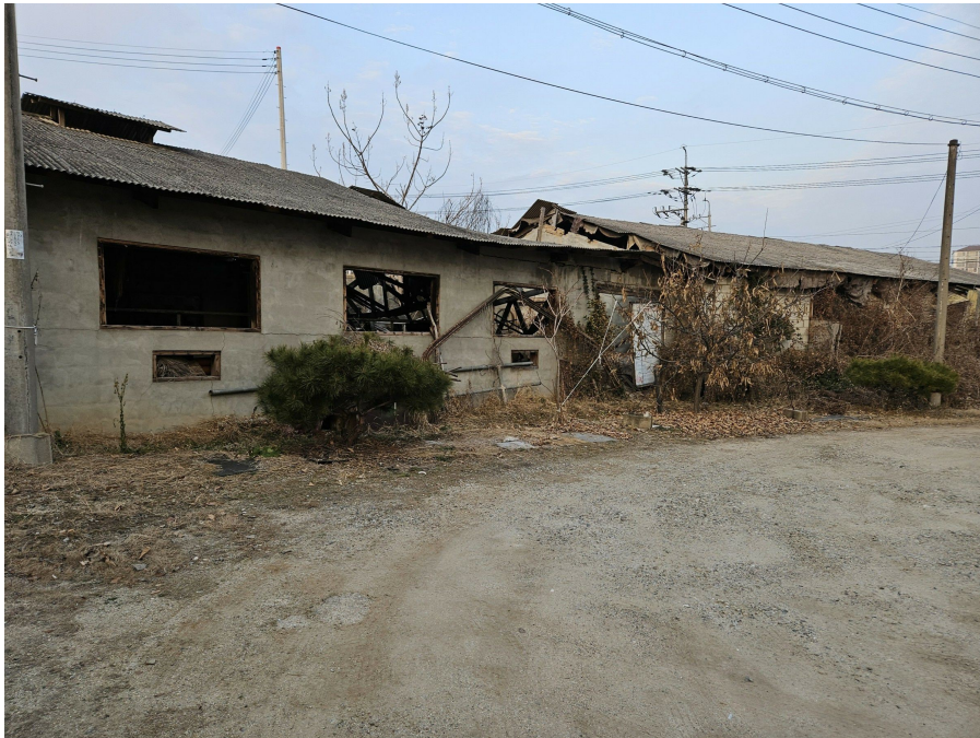
접면 도로(기호 2, 4 남측 비포장도로)
