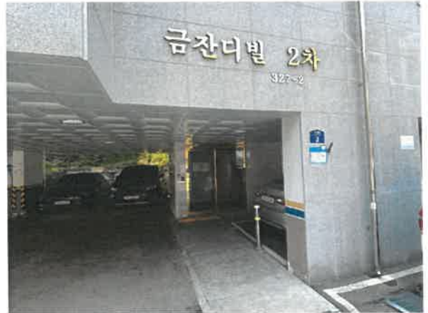
1층 공동출입문 전경
