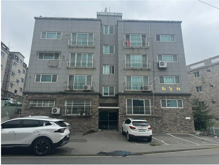
본건 건물 전경
