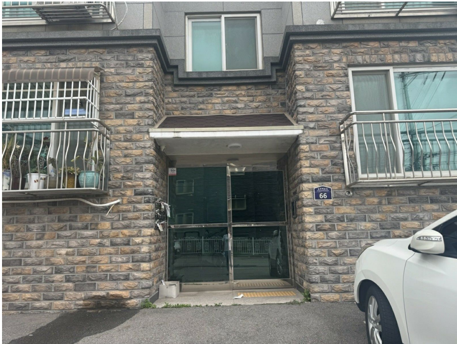
본건 1층 출입문
