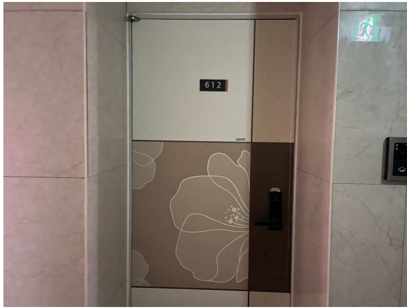
본건 현관출입문 전경
