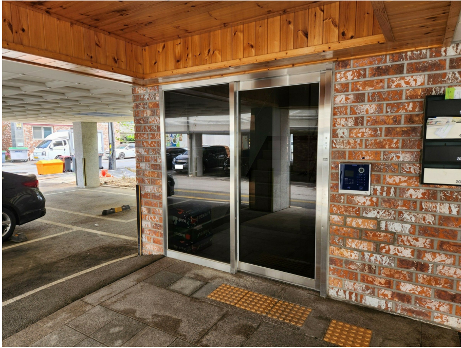
본건 공동 출입구
