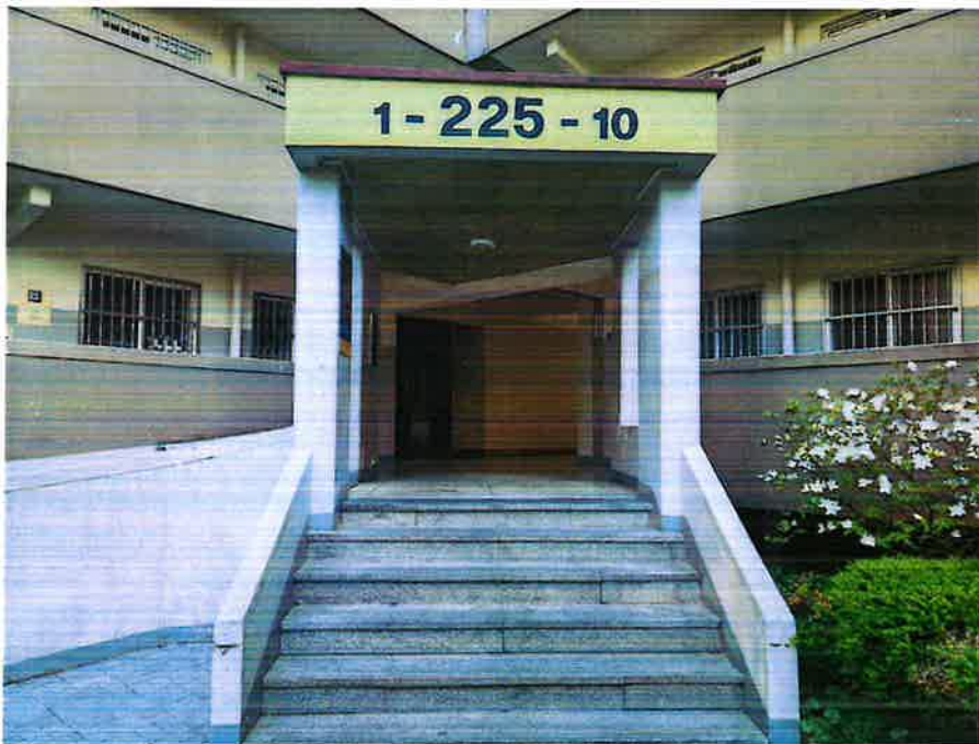
1층 출입구 전경
