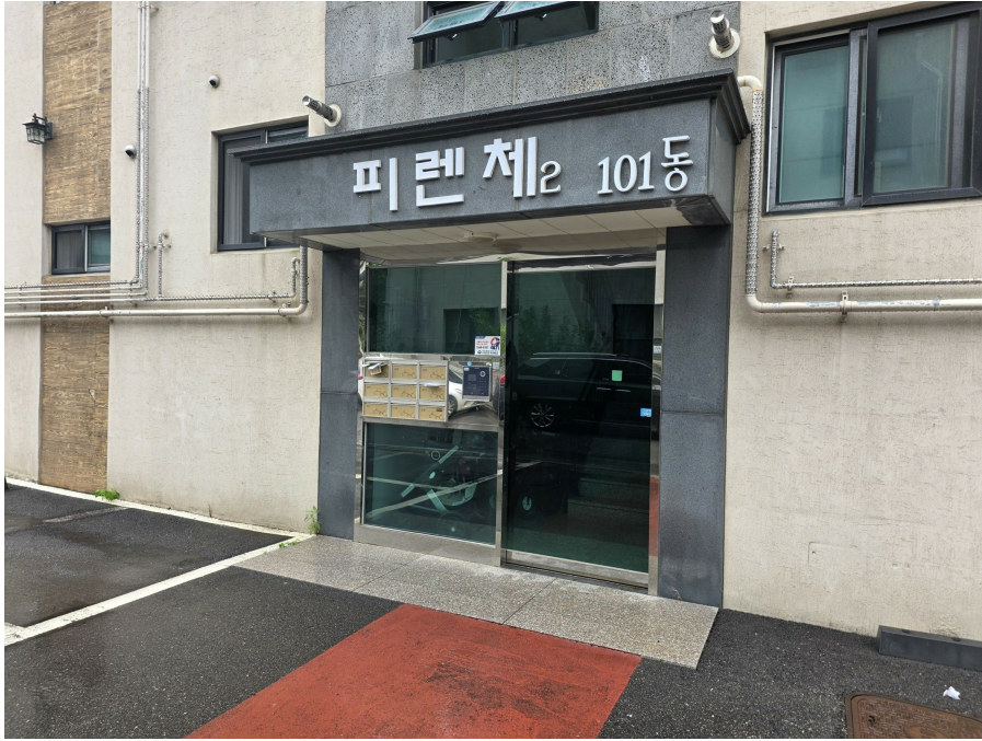
본건 공동 출입구
