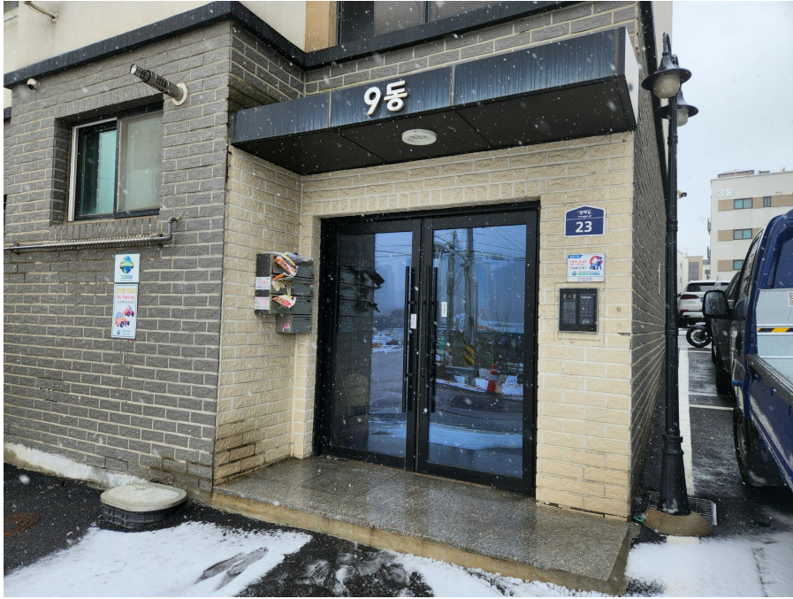
본건 공동 출입구
