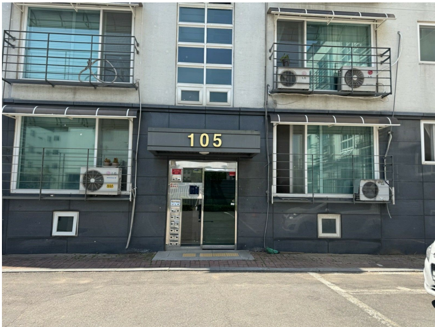
105동 1층 출입문
