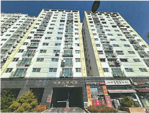
본건 건물 전경
