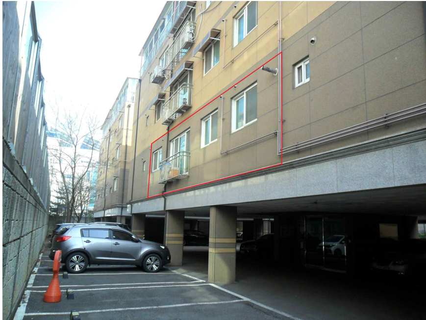
대상물건 전경 (북서측에서 촬영)
