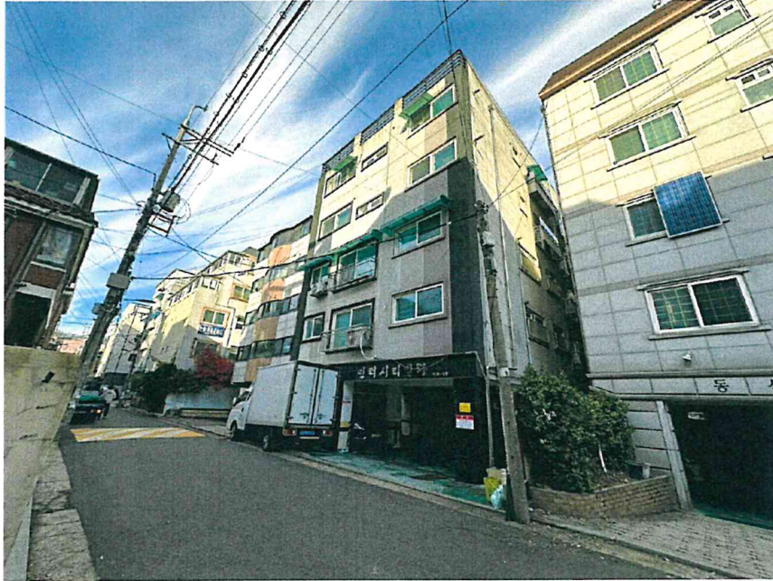
<본건 건물 전경>
