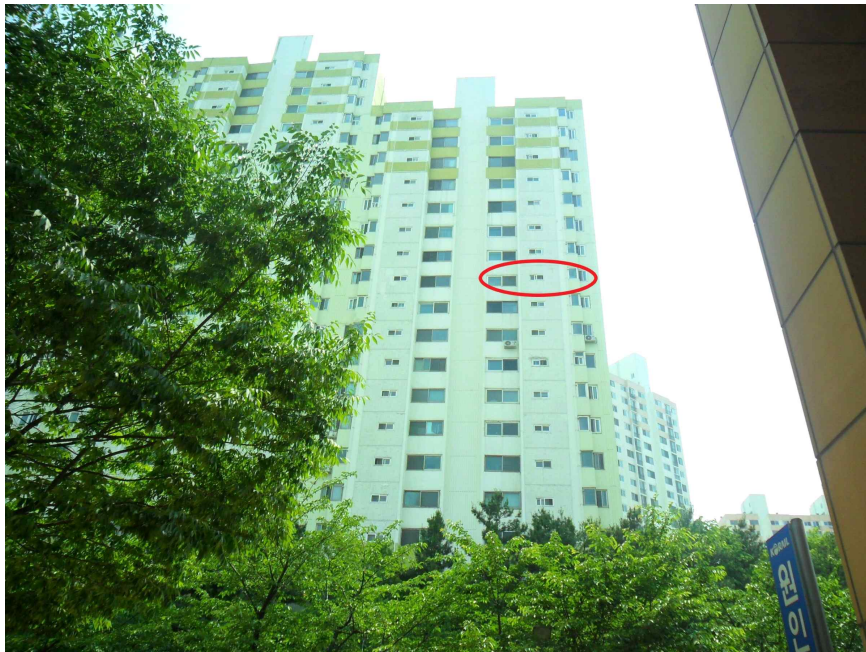
대상물건 전경 (북동측에서 촬영)
