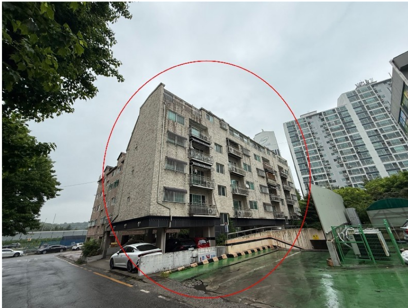
【본건 전경 - 남서측에서 촬영】
