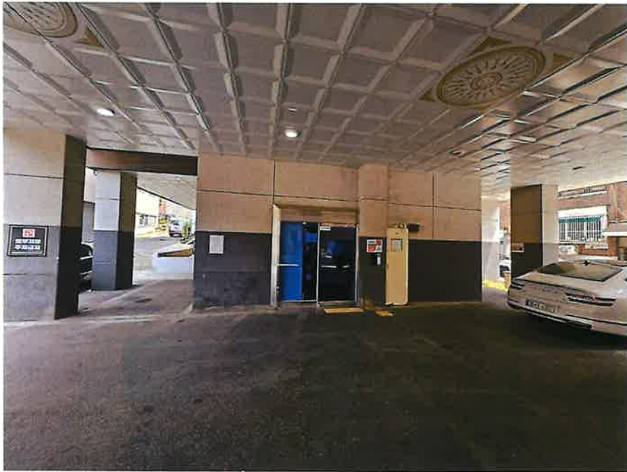
대상물건 공동현관문 촬영
