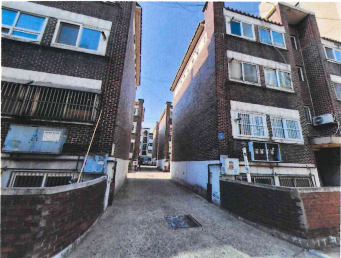
본건 북동측에서 촬영
