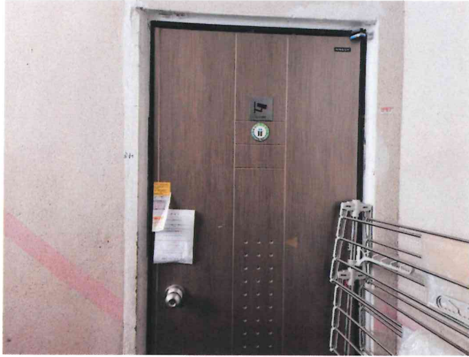
본건 출입구 사진
