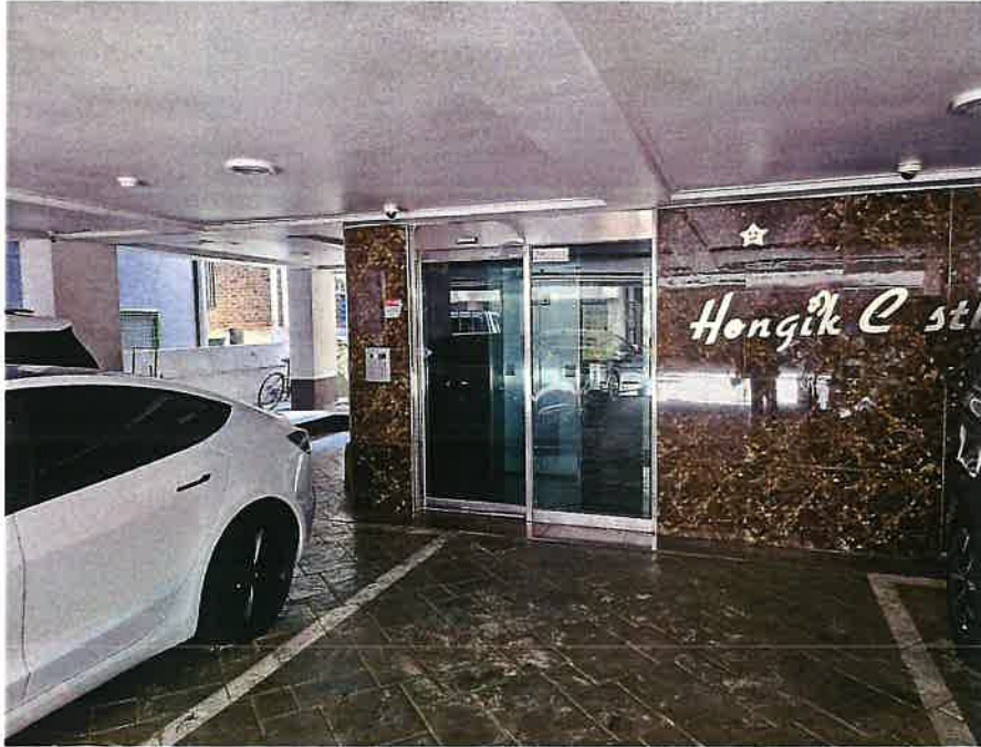
본 건물 주출입구 전경
