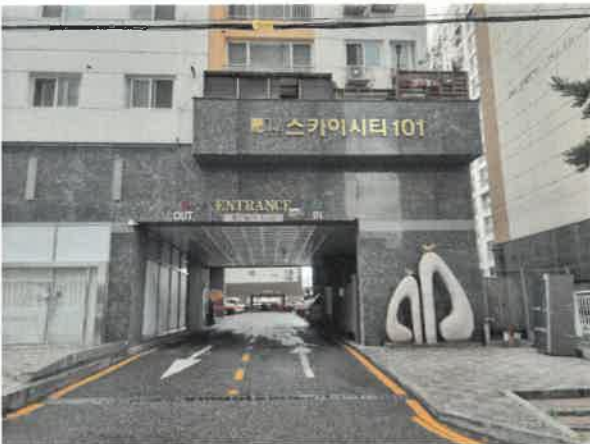
본건 소재 건물 주차장 출입구
