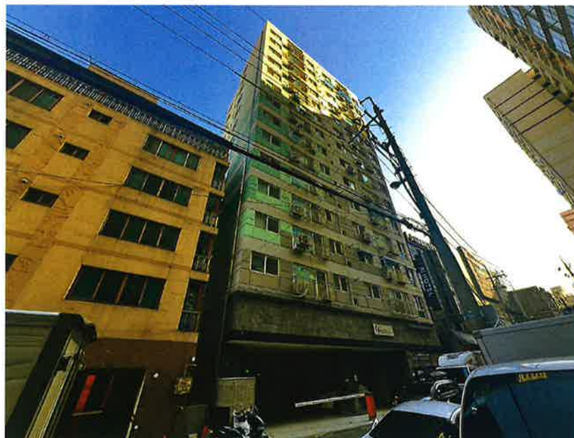
【 대상물건 전경[북서측에서 촬영] 】
