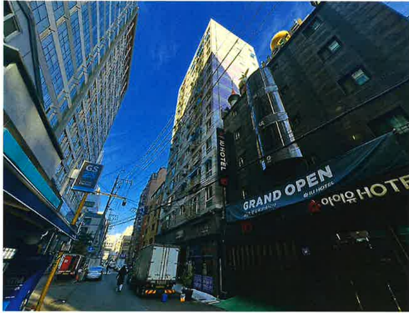
【 대상물건 전경[남서측에서 촬영] 】
