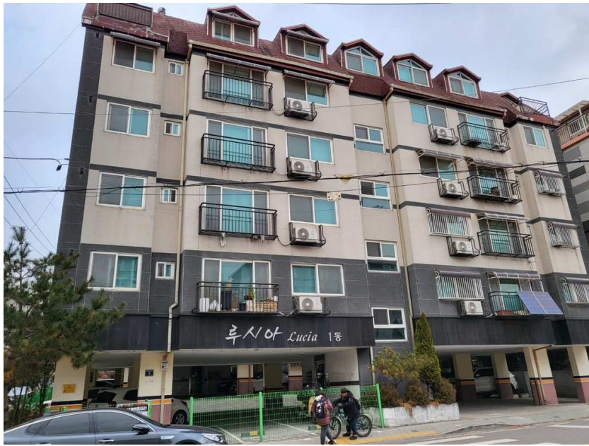
본건 건물 전경
