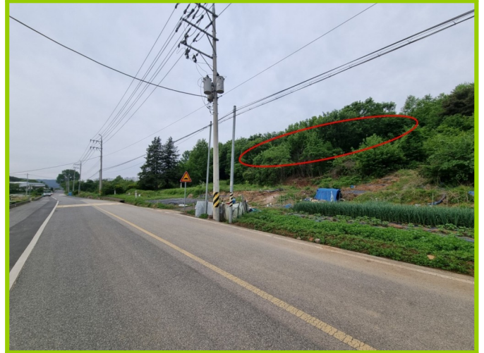
1 주위환경 (북동측에서 촬영)
