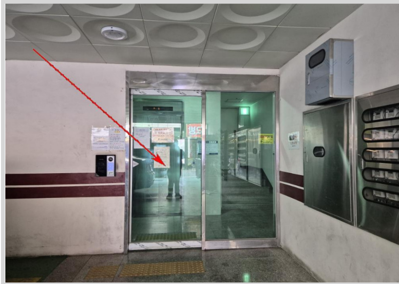
공동 현관문 사진
