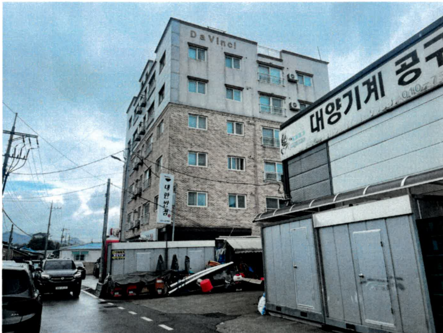
본건 건물 외관 및 접면도로
