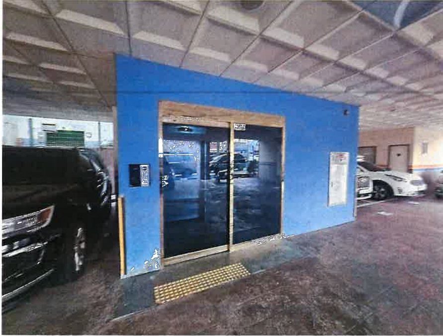
본건 주출입구 전경
