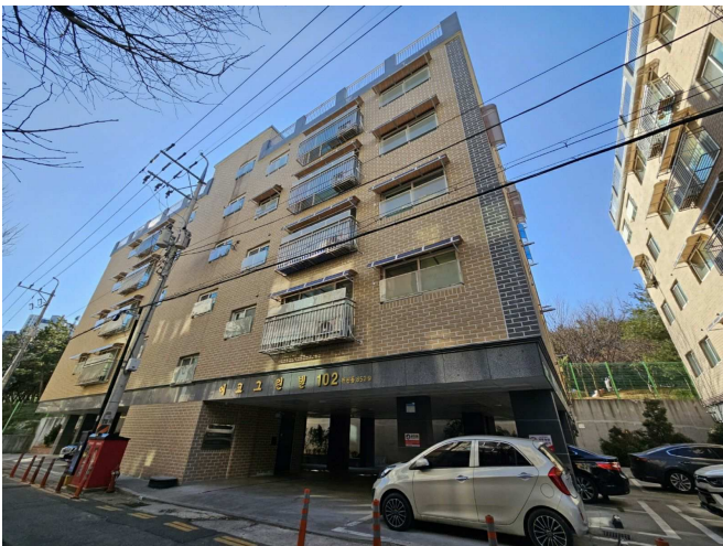
[본건 전경] 본건 동측에서 촬영
