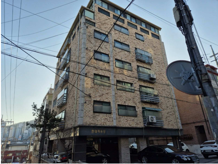
본건 (현대하우징) 전경(북동-> 남서방향)
