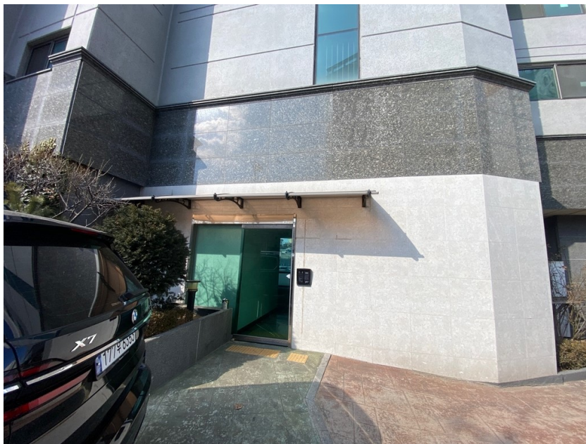
1층 출입구 전경
